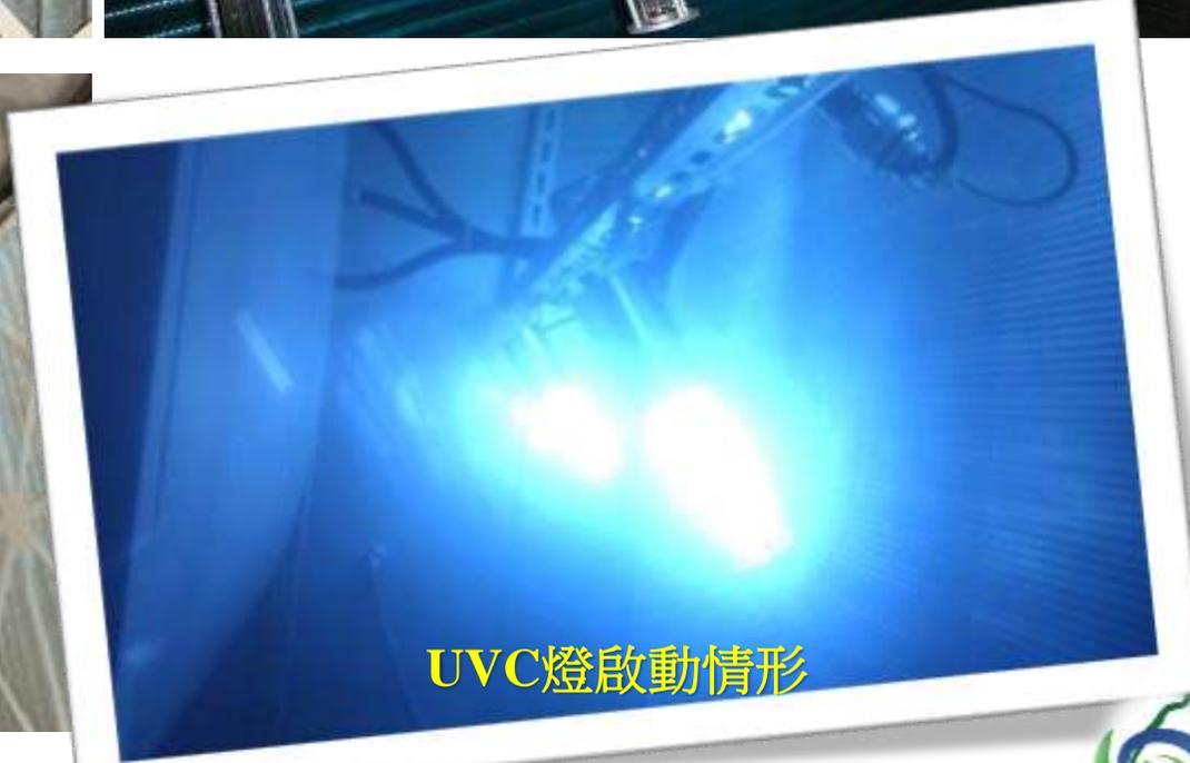
圖3-22 場址採用UVGI系統結合袋式濾網之空調箱淨化系統
