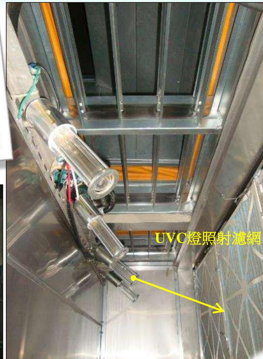
圖3-15 中央空調系統空調箱內部設置UVGI淨化設備
